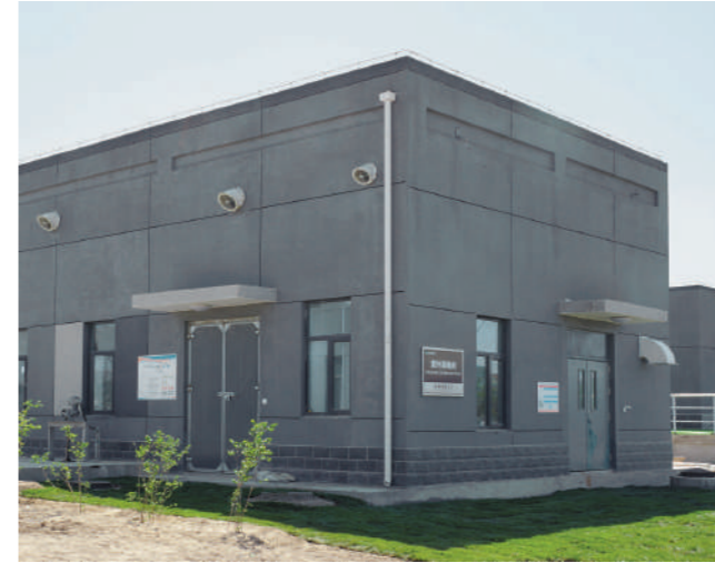
污水处理厂，中国，北京，78 万吨/天
